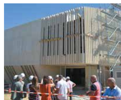
Visite de chantier Espace jeunesse
