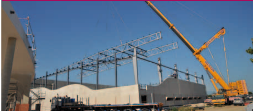
Le 7 juillet, deux des immenses charpentes métalliques ont été placées au niveau de la salle omnisports du Complexe couvert de la Germanor, soulevées par l'impressionnante grue de 350 tonnes. La charpente totale de cette salle représente un poids de 100 tonnes.
