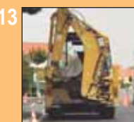
13 Chantiers et grands projets
