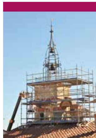
Mise en place du clocheton de l'église Notre-Dame-des-Anges.
